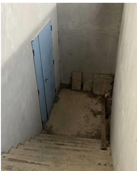
Porte métallique 2 vantaux avec 1 tierce accès R-1
