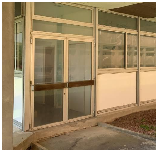
Porte en aluminium à remplacer façade RDC sur le retour
